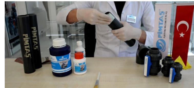
Boru ve soketin temizlenmesi
